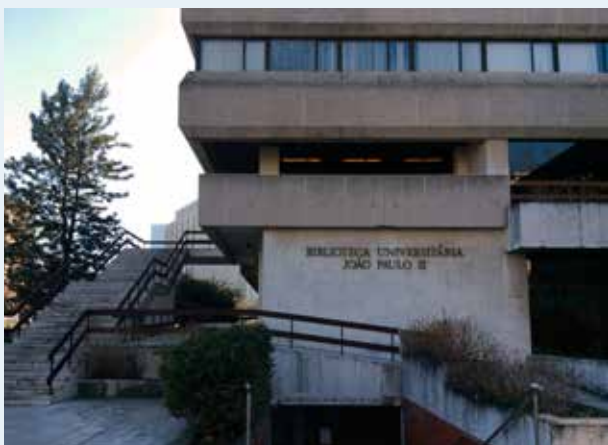
Edifício da Biblioteca Universitária João Paulo II: entrada lateral e fachada norte
